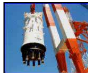
原子炉圧力容器据付
