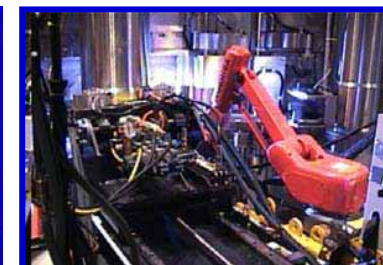
炉内溶接ロボット
