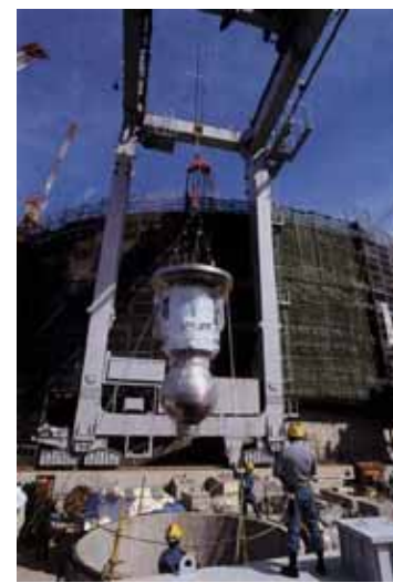
2次主循環ポンプ
