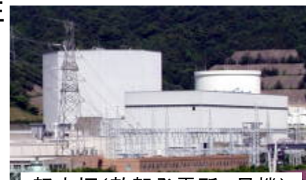
軽水炉(敦賀発電所2号機)
