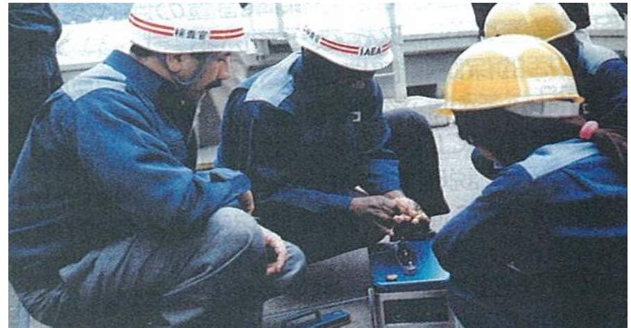
監視カメラの取り付け
